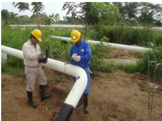
Medición de potenciales en el ducto.
