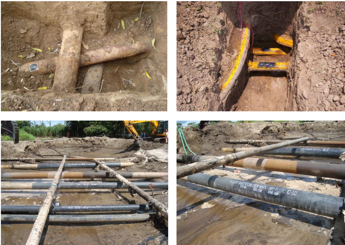
Figura A1. Disposición compleja de ductos en DDV compartido.
